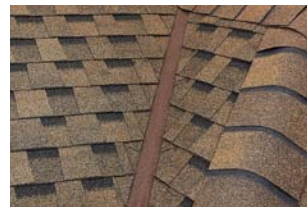
Калифорнийская ендова (один из вариантов открытого способа)
